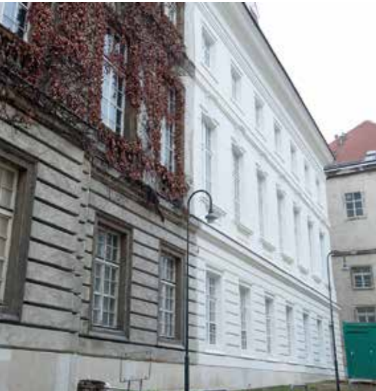
ganz unten: Josephinum vor Beginn der Sanierungsarbeiten
